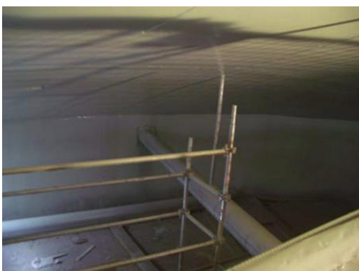
Aplikace hydroizolačního nátěru
