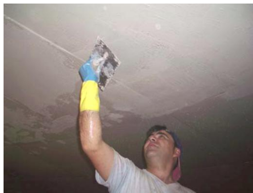
Aplikace vyrovnávacího tmele
