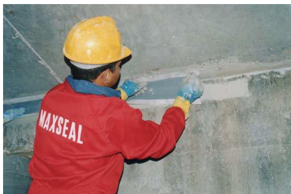
Lepení elastického pásu MAXFLEX XJS
