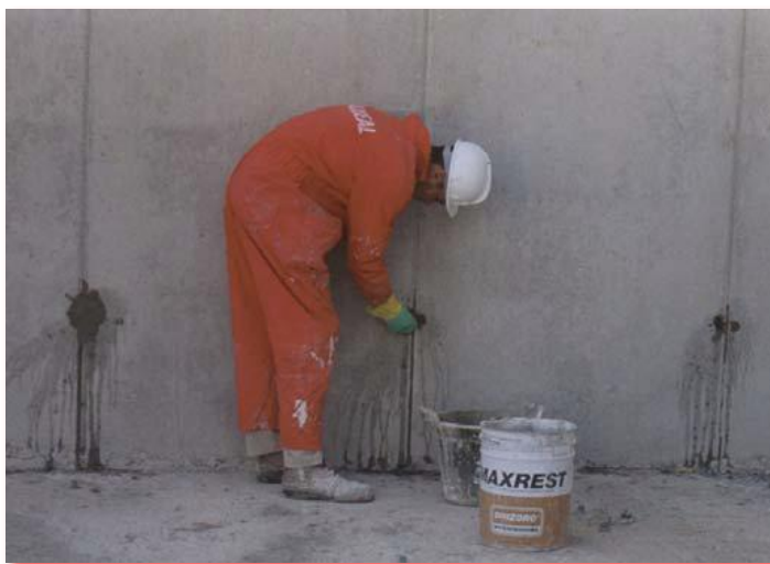
Utěsnění prostupů táhel systémového bednění
