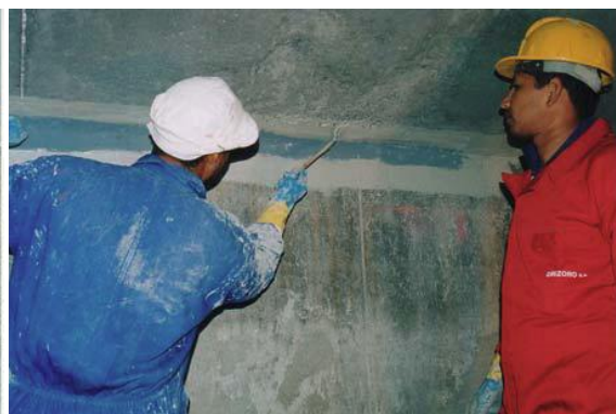
Závěrečná úprava pásu MAXEPOX BOND-G
