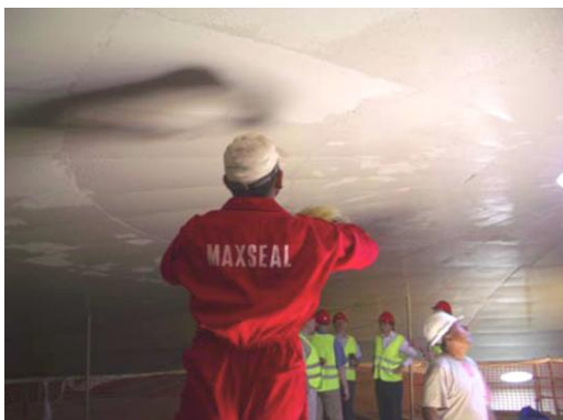
Aplikace primárního nátěru
