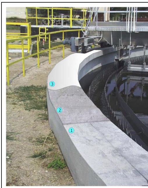
Obr. 13 – Úprava pojezdu zhlaví
