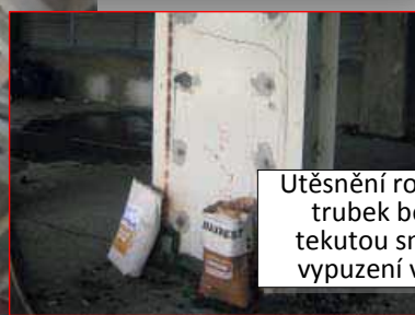
Pohled na detail úplně zálivky bednění
