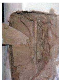
Aplikace malty na čerstvý spojovací můstek vtlačení směsí
