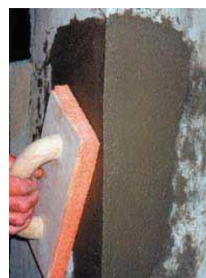
Estetické dokončení opravy
