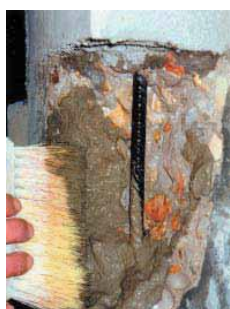
Aplikace spojovacího můstku řídkou kaší ze stejného výrobku
