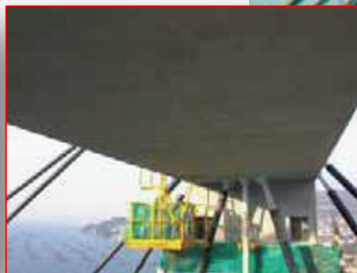
Aplikace flexibilní a hydroizolační stěrky MAXSEAL® FLEX jako hydroizolace a ochrana proti různým vlivům
