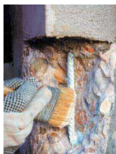
Očištění povrchu a aplikace pasivátoru oxidů
