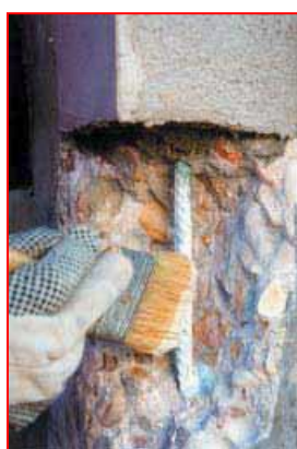
Očištění povrchu a aplikace pasivátoru oxidů a ochrany MAXREST® PASSIVE
