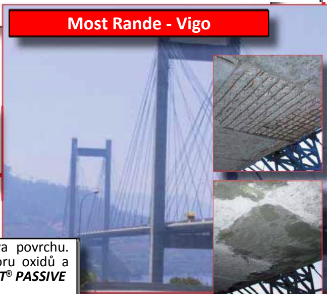
Po vyžrání se oxidy transformují do ochranné vrstvy
