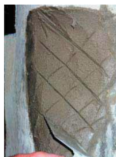
V případě provádění více vrstev narýhovat povrch předchozí vrstvy
