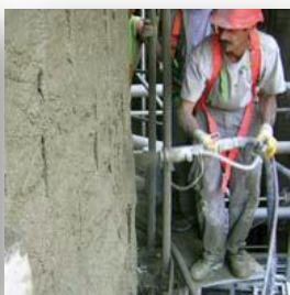
Dovolují tloušťky vrstev do 5 cm metodou nástřiku
