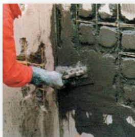
Vynikající tixotropie, která urychluje prováděcí proces
